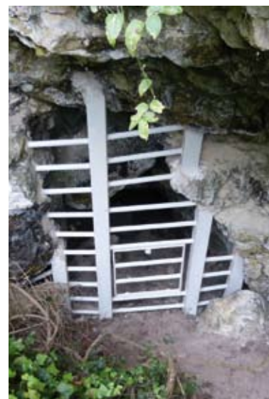
Grille à l'entrée de la cavité de Vétheuil
