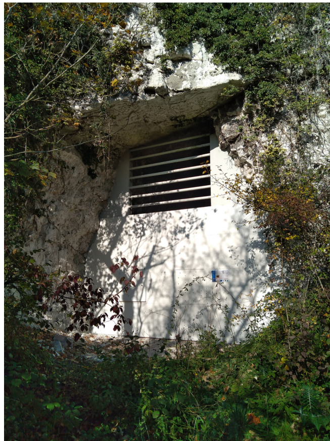
Dispositif de fermeture de la cavité de Follainville-Dennemont © PNR-VF
